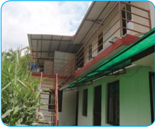
भवन नं. २ को तला माथि कोठाहरु निर्माण
