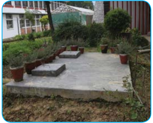
सेप्टिक ट्यांक निर्माण
